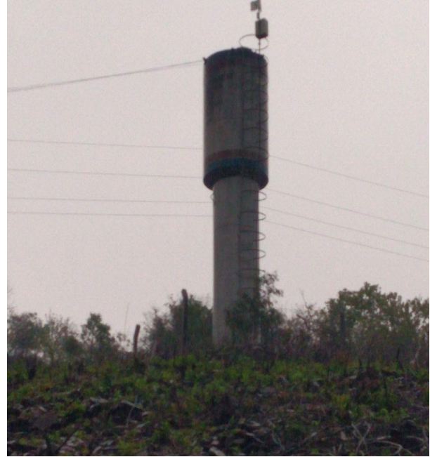
Figura 47 – Reservatório localizado na Sociedade de Água Linha Somavilla (metálico com capacidade de 15m 3 )
