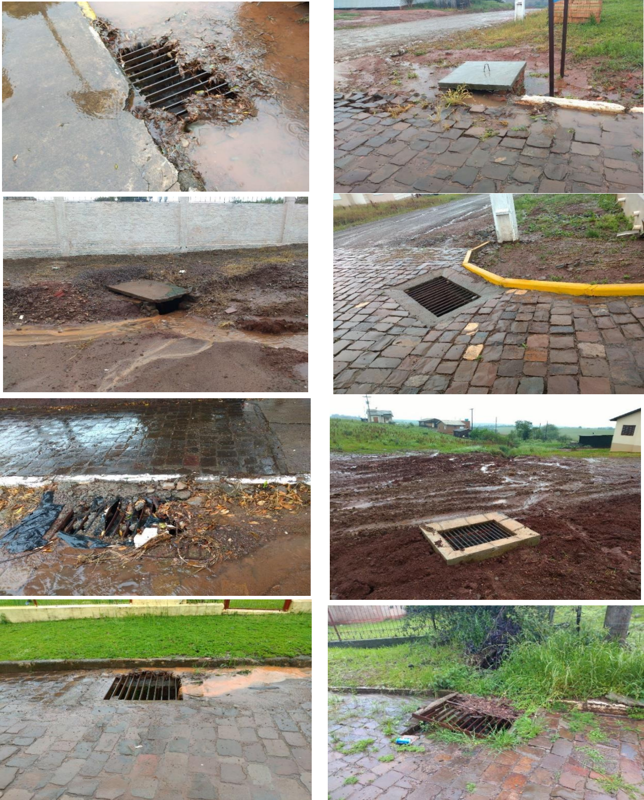
Figura 67 – Exemplos de bueiros situados na zona urbana e Distritos do município de Estrela Velha/RS
