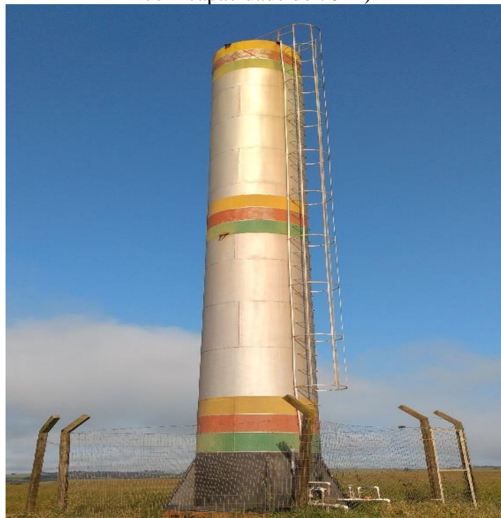
Figura 61 – Reservatório de água na Sociedade de água Linha Vassouras (metálico com capacidade de 70m 3 )
