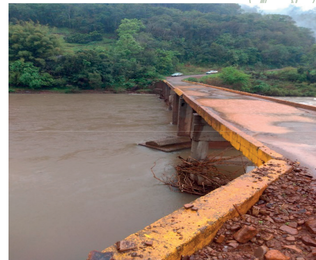
Ponte sobre o Rio Jacuzinho no município de Estrela Velha/RS (acesso do Distrito de Itaúba ao município de Arroio do Tigre/RS)
