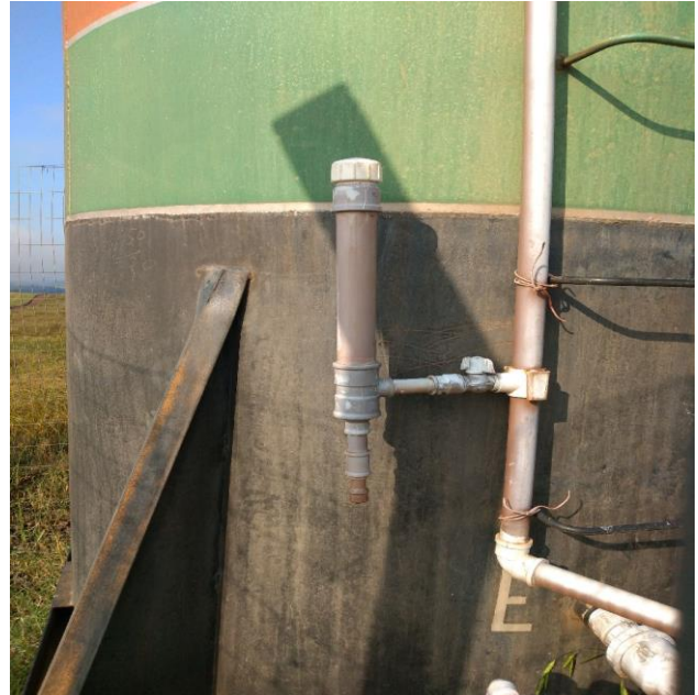
Figura 60 – Dosador de cloro tipo pastilha junto ao reservatório na Sociedade de Água Linha Vassouras
