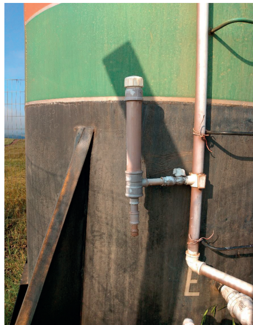
Dosador de cloro do tipo pastilha – Linha Vassouras
