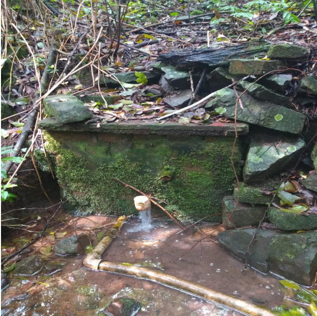
Figura 21 – F1 – Próxima a galeria do lajeado ao sentido ao Arroio do Tigre à Itaúba (Zona rural)
