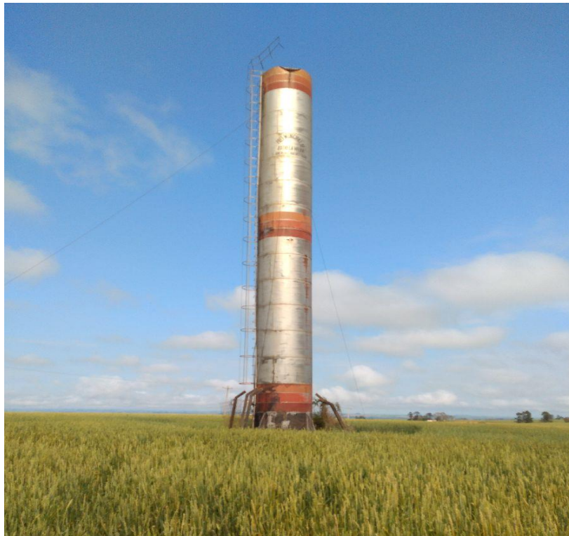
Figura 63 – Reservatório de água na Sociedade de Água Imaculada Conceição - Rincão dos Padilhas
