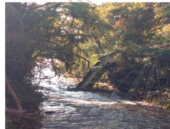
Ponte caída - Linha Vassouras
