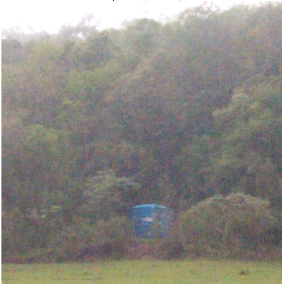
Figura 50 – Reservatório localizado na Sociedade de Água São Marcos (fibra com capacidade de 15m 3 )
