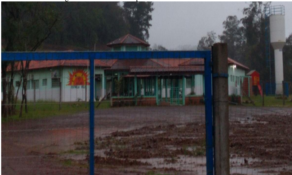
Figura 9 – Escola Municipal de Ensino Fundamental 25 de Julho
