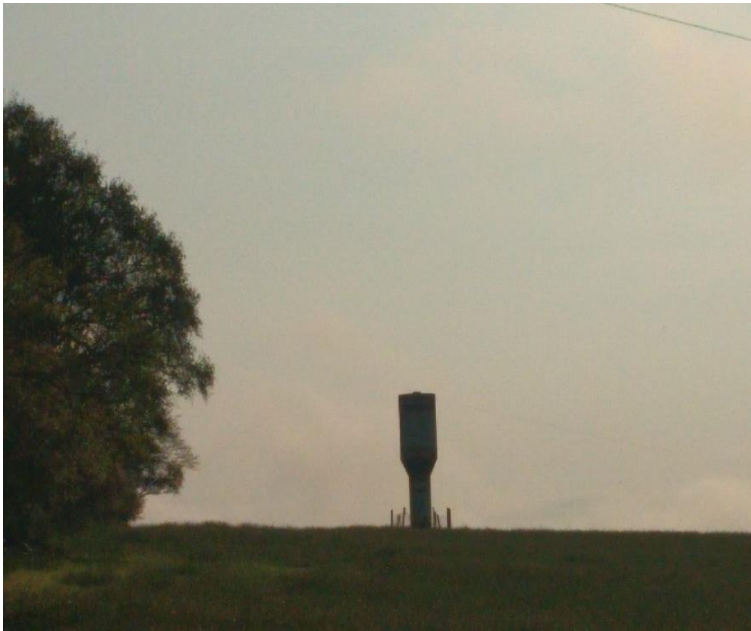
Figura 58 – Reservatório (metálico de 20m 3 ) localizado na Sociedade de Água Colônia Juvenilia
