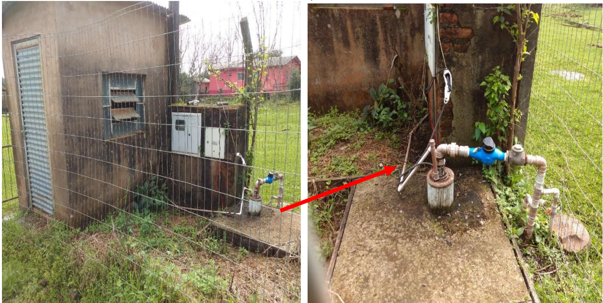
Figura 64 – P20 : Localização do poço na Sociedade de água Rincão dos Corrêa e Órfão (Zona rural)
