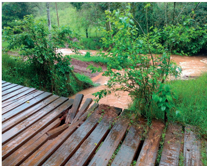
Ponte de madeira - Distrito São Luiz
