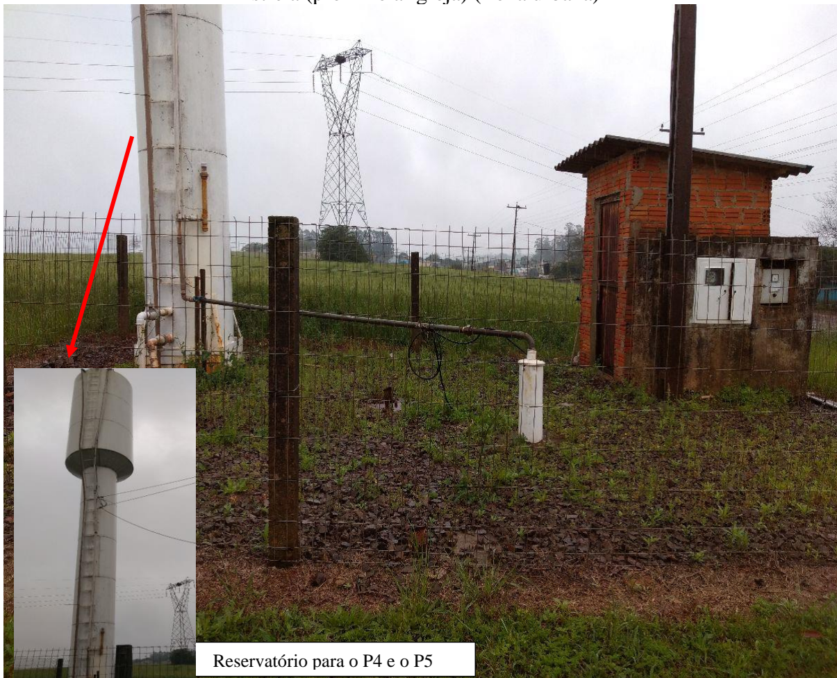
Figura 30 – P5 e Reservatório: Av. Jausino Fernandes de Camargo - Rincão da Estrela (próximo a Igreja) (Zona urbana)
