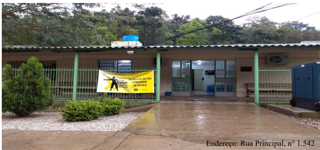
Figura 7 – Unidade Sanitária do Distrito de Itaúba do município de Estrela Velha/RS
