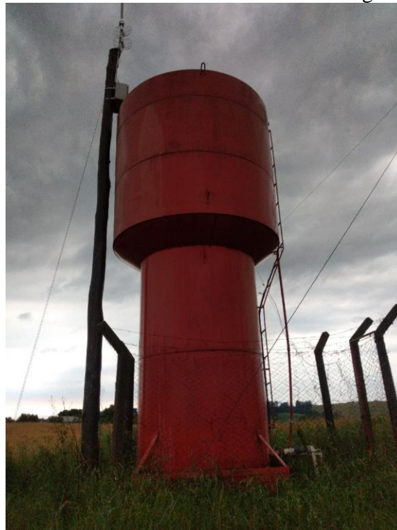
Figura 54 – Reservatório localizado na Sociedade de Água Linha das bicas
