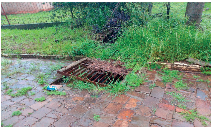
Bueiro na zona urbana
