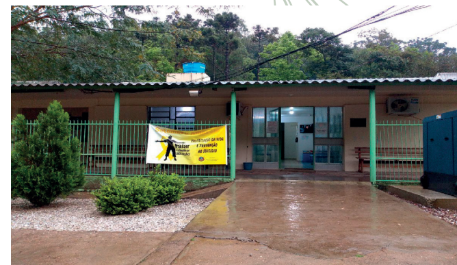
Unidade Sanitária do Distrito de Itaúba
