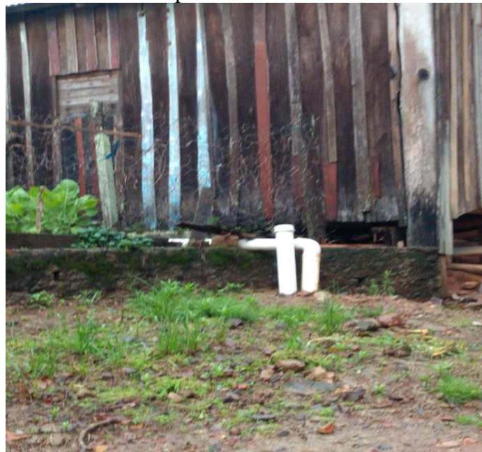
Figura 66 – Tubulação superficial de esgotamento sanitário (fossa séptica) em residência na zona rural do município de Estrela Velha/RS
