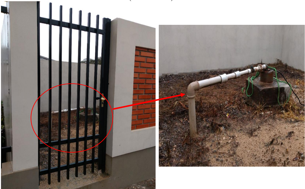
Figura 28 – P3: Av. João Luiz Billig (em frente ao Centro de Tradições Gaúchas) (Zona urbana)
