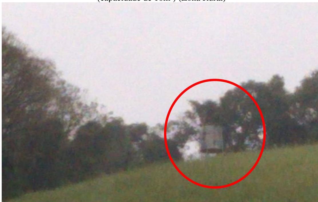
Figura 39 – Reservatório intermediário da Sociedade de Água da Linha Santa Terezinha (capacidade de 10m 3 ) (Zona Rural)
